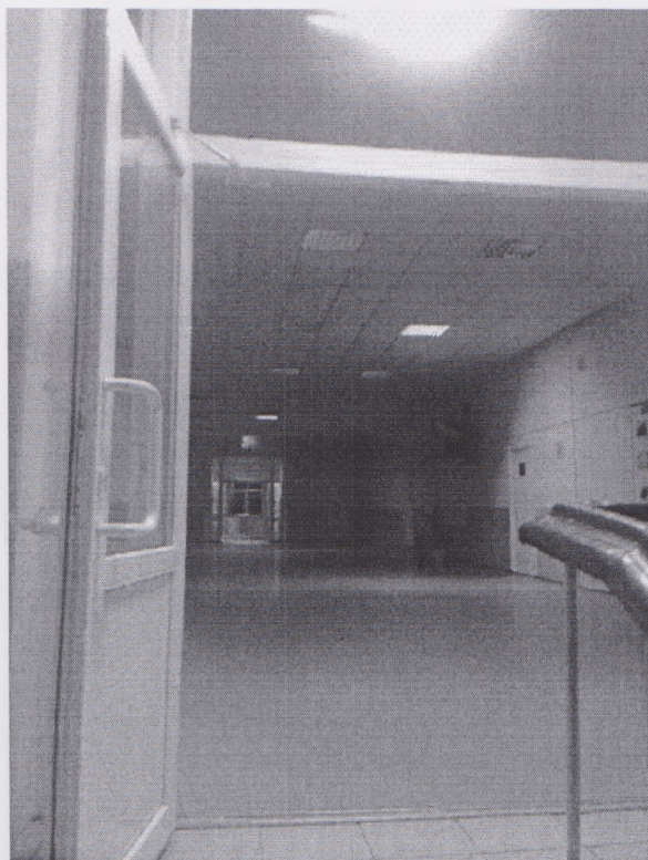
Рис. 22 Двери второго этажа (левые)
