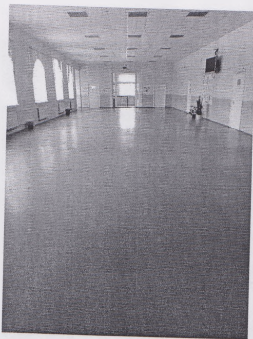
Рис. 21 Холл второго этажа (левая)
