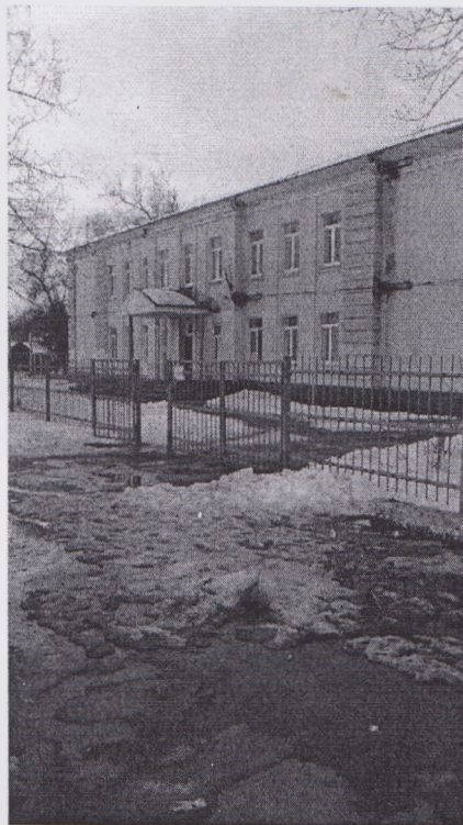
Рис. 1 Вход на территорию МБОУ СШ № 2 со стороны ул. Ленинградская
