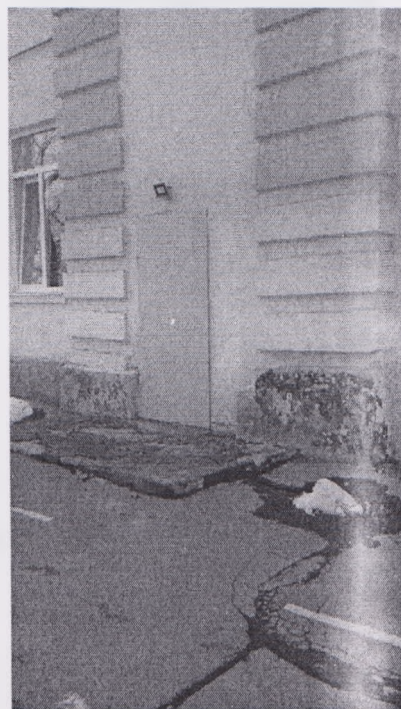
Рис. 9 Входная площадка перед дверью (запасной вход, правый).
