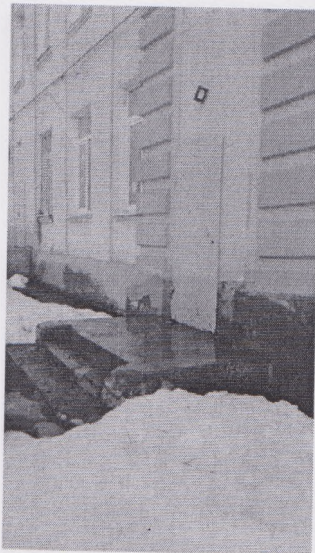
Рис. 12 Входная площадка перед дверью (запасной вход, левый)
