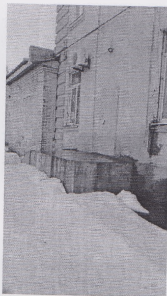
Рис. 13 Входная площадка перед дверью (запасной вход, левый, бухгалтерия)
