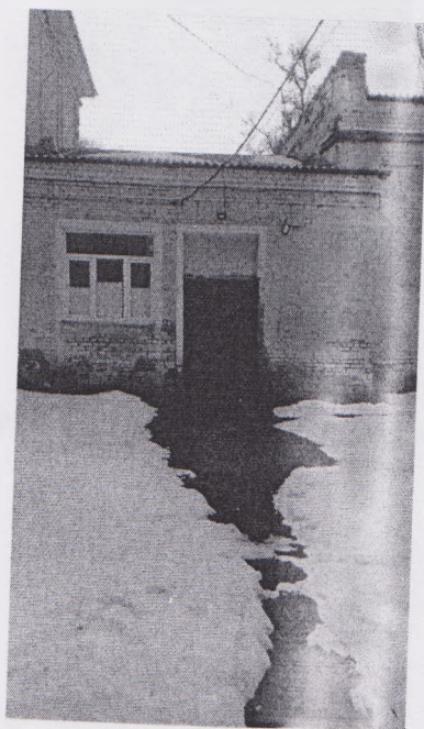
Рис. 11 Входная площадка перед дверью (запасной вход, спортивный зал)
